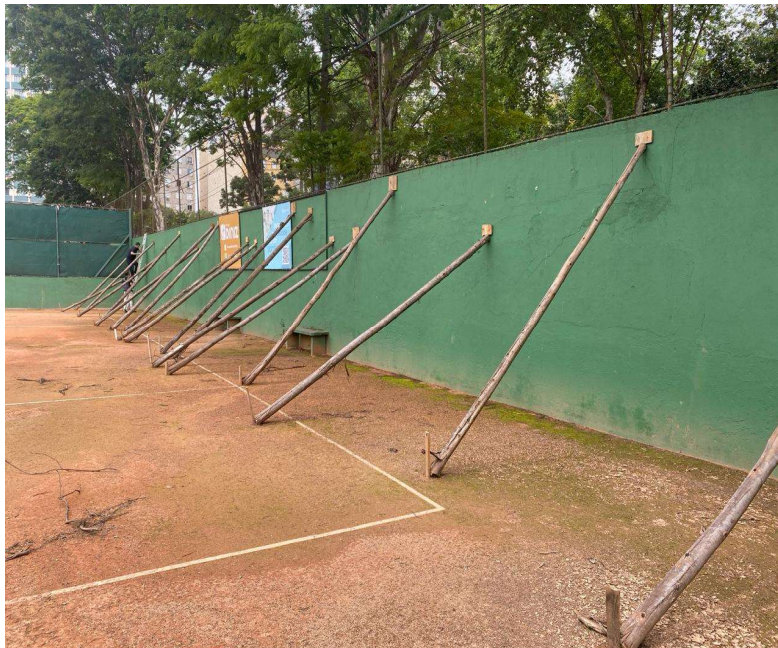
17| Vista interna de muro de divisa no alinhamento com via pública com cimbramento em madeira executado.
