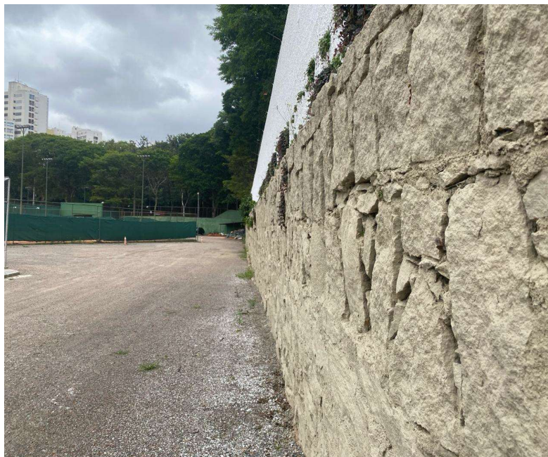
23| Vista interna do muro de arrimo vistoriado.
