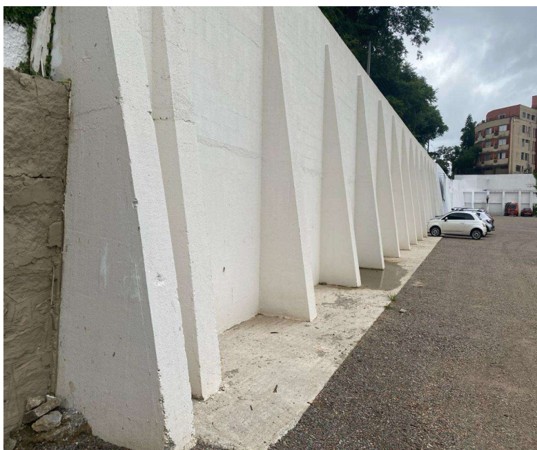
26| Vista de muro de arrimo com contrafortes executado.
