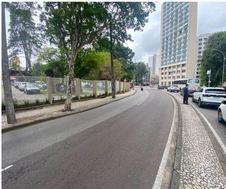
27| Vista de gradil localizado no alinhamento predial do lote tomada em via pública (Rua Luiz Leão).
