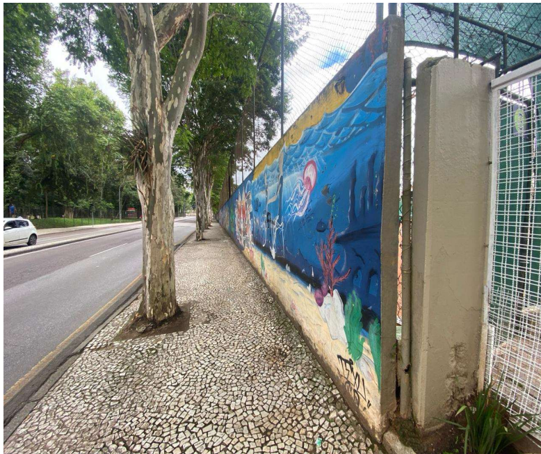
1| Vista externa de trecho de muro vistoriado na Rua Luiz Leão.
