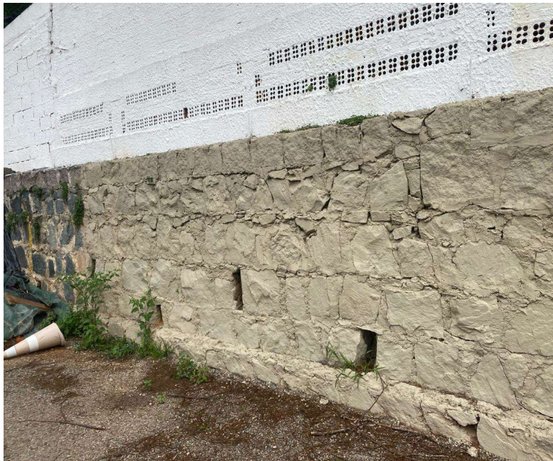
22| 21| Vista interna de muro de arrimo com diversos pontos de inclinação direcionada ao lote
